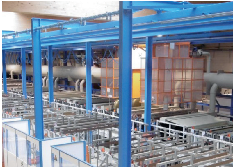
Traitement de surface sur ligne automatisée Dimension cuves : 3000 x 1500 x 600 mm Volume utile : 2700 X 1350 X 450 mm
